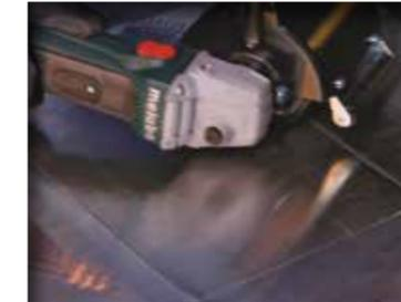
Im „Kreuzverfahren“ Schliffbild systematisch mit aufblasbarer Expansionswalze und Pyramid Schleifbänder A 45 / A 30 / A 16 / A 06 nacheinander aufbereiten auf Stufe 6\*.
