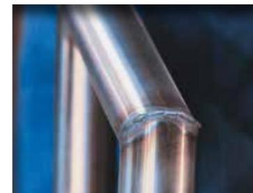
WIG-Schweißnaht an einem Handlaufwinkel.
